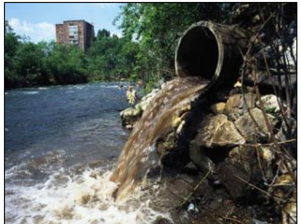
Imagen 16: Vertido de aguas sin depurar a un cauce fluvial.
