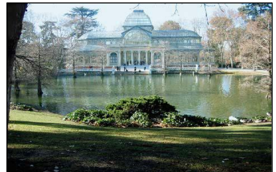
Imagen 12: Palacio de Cristal del Parque del Retiro de Madrid. Fuente: Materiales Virtuales ESPA LOE
